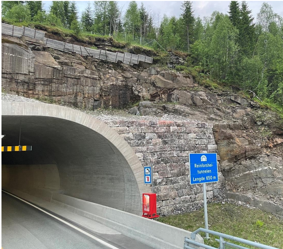
Foto 8: Nordlige påhugg med gjerde over portalen, og med stablede blokker rundt portalen.
