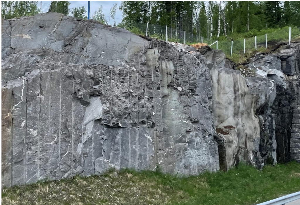
Foto 7: Søndre påhugg venstre side med bolter og sprøytebetong.
