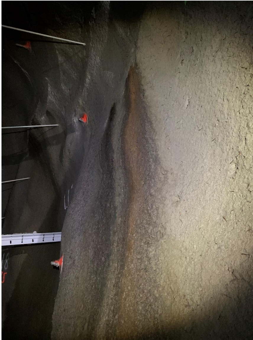
Foto 3: Fukt bak hvelv. Pel 84, høyre side.
