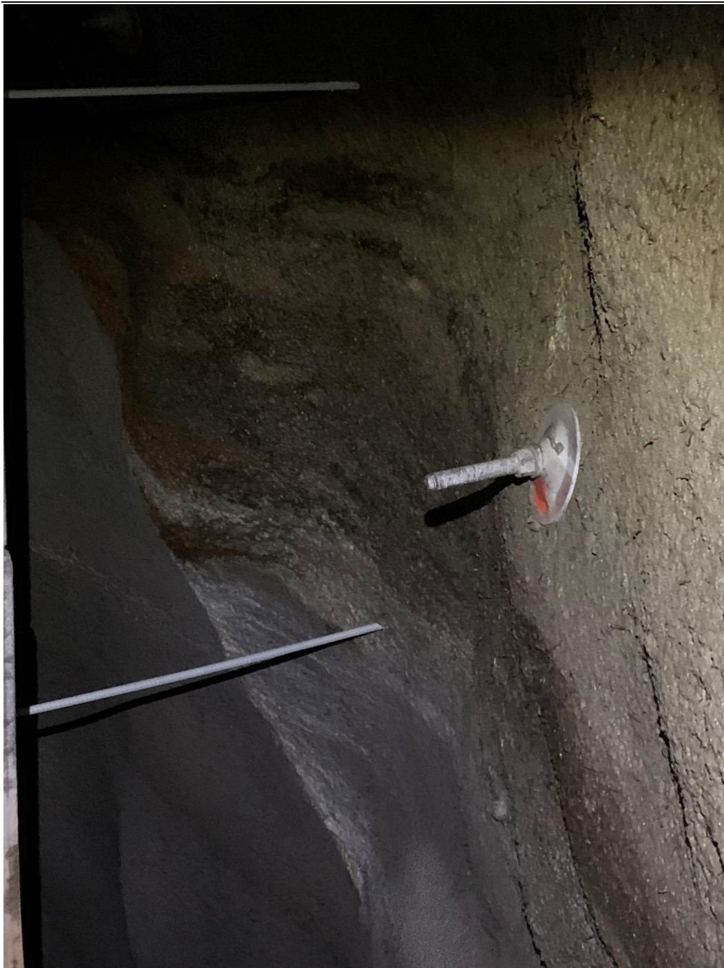
Foto 2: Fukt bak hvelv. Pel 84, høyre side.
