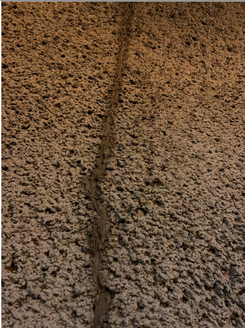
Foto 1: Fugede sprekker mellom betongelementer. Alle registrerte sprekker er fuget godt, tilsvarende det som er vist på bildet.
